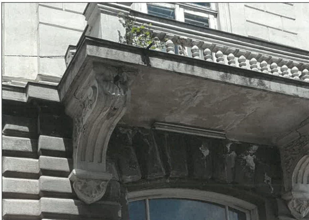
Balcon, fațada laterală dreapta - detaliu privind migrația și recristalizarea sărurilor / elemente vegetale
