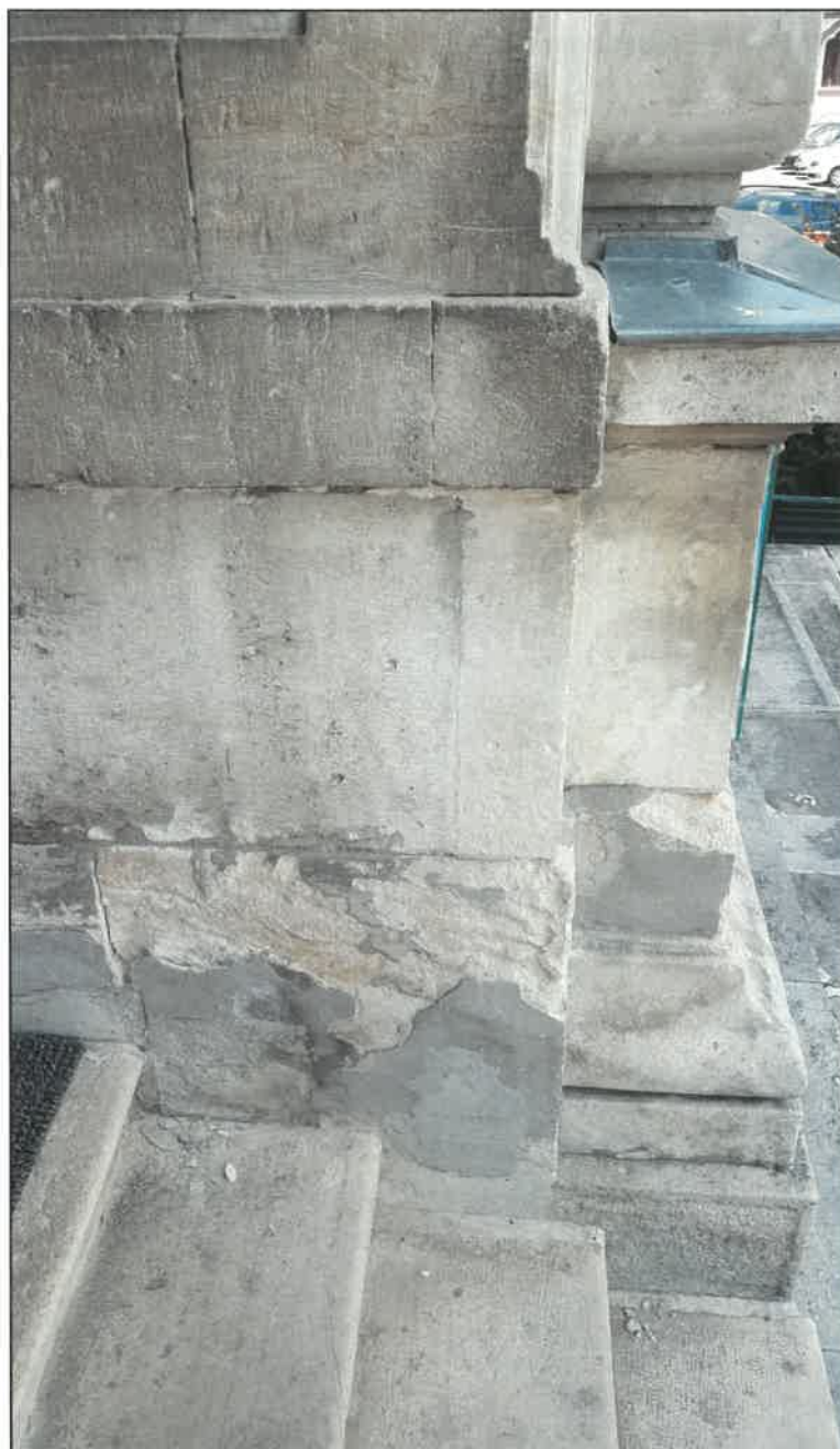
Intrarea principală - detaliu privind intervențiile necorespunzătoare și consecințele umidității de capilaritate
