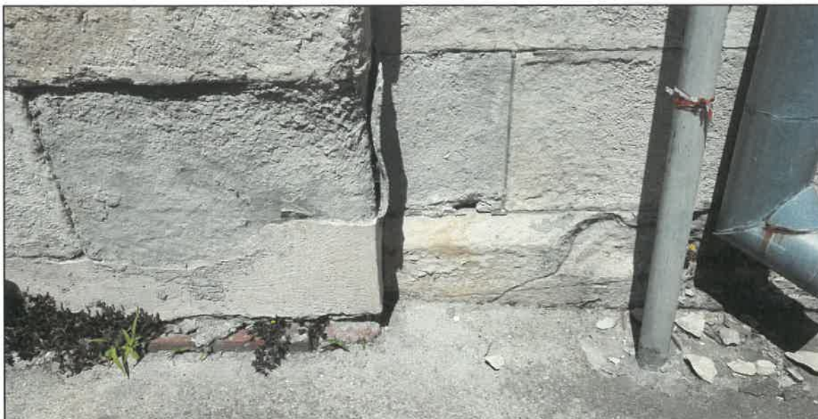
Soclu - detaliu privind intervențiile necorespunzătoare și consecințele umidității de capilaritate
